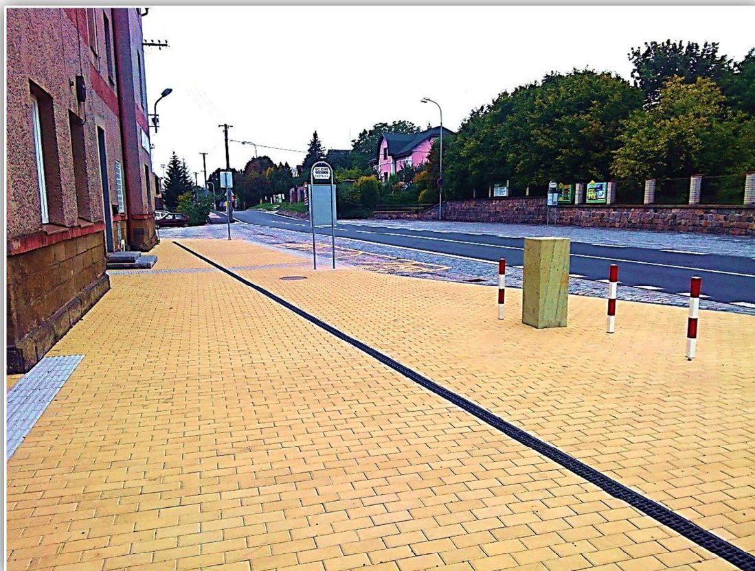
Rekonstrukce Nádražní ulice v prostoru před vlakovým nádražím. (stav před a po rekonstrukci) - vyfoceno 8. 4. a 26. 9. 2015, autor L. Šimek)
