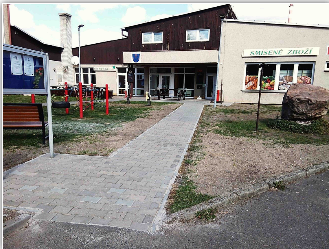
Úprava chodníku k místní prodejně/restauraci/penzionu (vyfoceno 17. a 26. 9. 2015)
