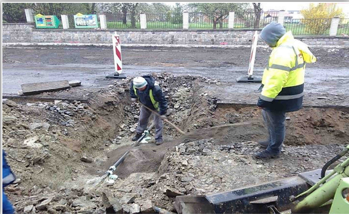
Oprava po havárii plynového potrubí v ulici Nádražní (vyfoceno 28. 4. 2015, autor L. Šimek)
