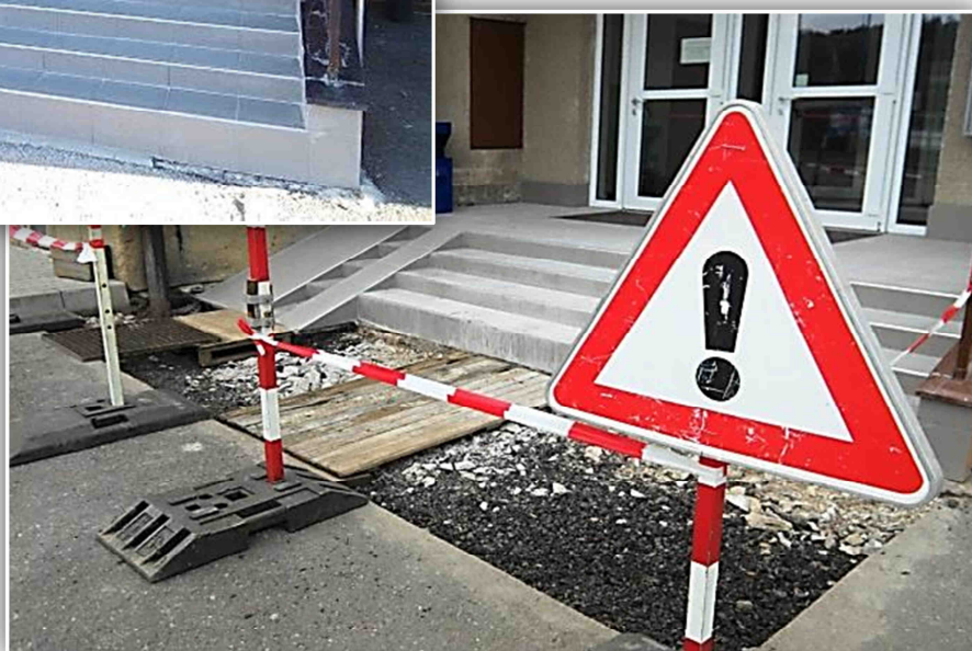
Rekonstrukce schodů do tělocvičny (vyfoceno 14. a 27. 5. 2015, autor L. Šimek)
